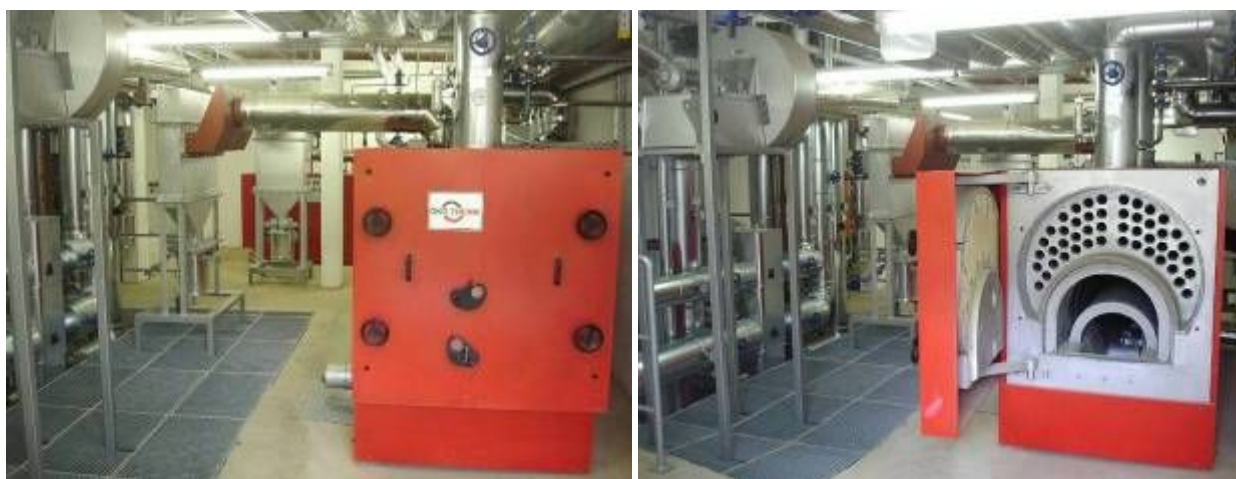
Abb. 13-14: Aufnahmen einer Compact-Heizanlage (275 kW), im Vordergrund ist der Brenner (rot) zu sehen, links daneben jeweils die Filteranlagen (Firma Ökotherm).
